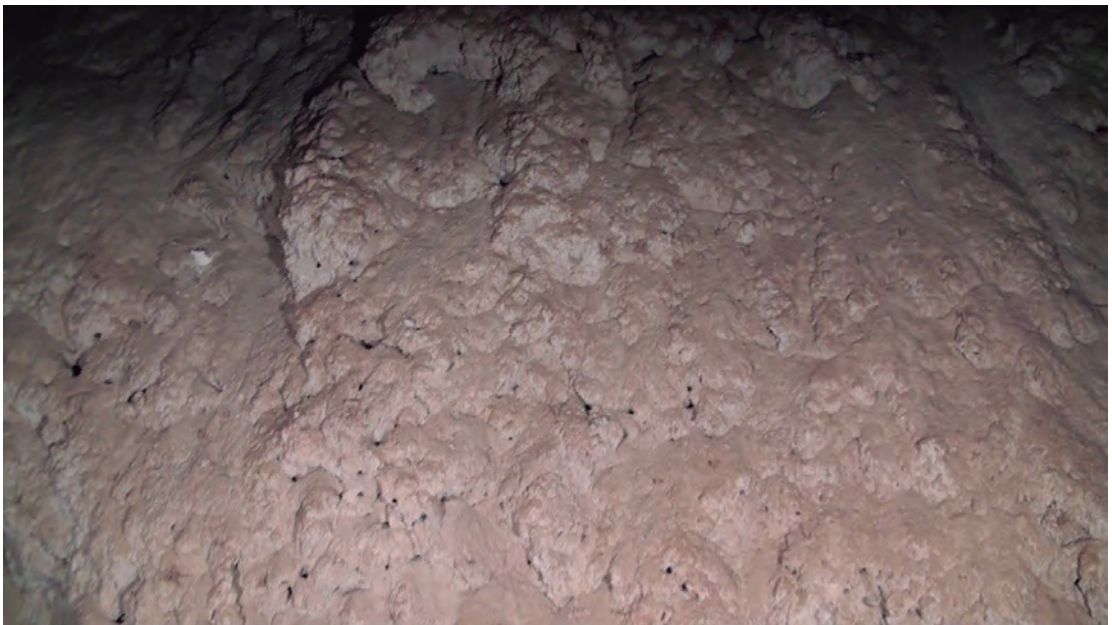
Figura 37. Fangs compactats amb galeries a l'escarpament d'Emile Baudot.
